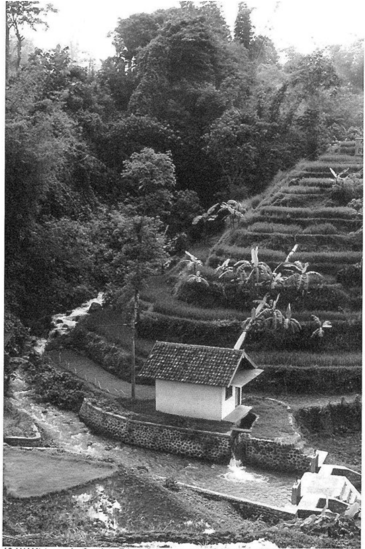
12 kW-Miniwasserkraftwerk im Tal mit Reisterrassen von Seloliman auf Ost-Java.
