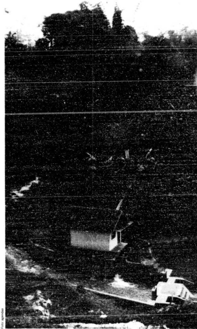
Das kleine Wasserkraftwerk in Ostjava versorgt ein Dorf mit 135 Einwohnern. Jeder Haushalt zahlt dafür umgerechnet sieben Mark.
